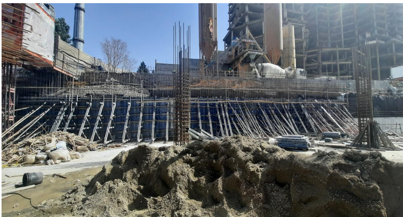
قالب بندی دیوار حائل ضلع شرقی طبقه 1- پارت 1 _ اسفند 1400
